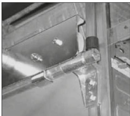
Montieren Sie die Endanschläge sie werden mit Blechschauben an den Schienenhaltern befestigt.
