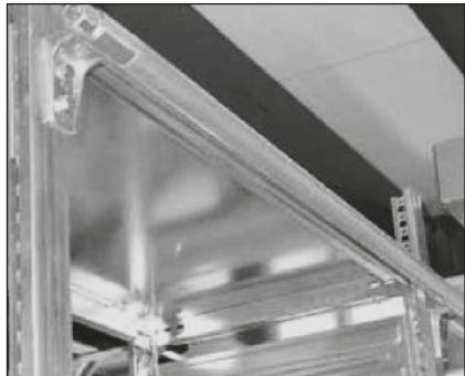
Schieben Sie die Seitenführung in das Querrohr.
