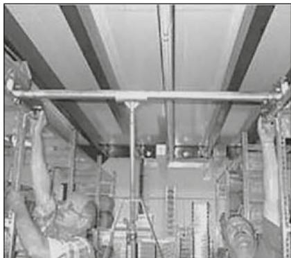
Schieben Sie das komplette Fahrwerk mit einer zweiten Person in die Schienenführung.
